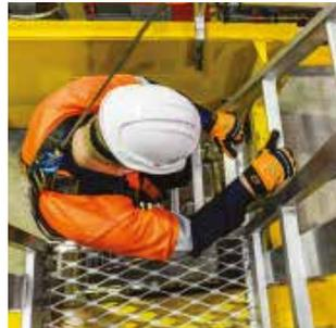
11. Wiederholen Sie den ersten HSG-Test, indem Sie schnell am Kabel nach unten ziehen, um zu überprüfen, ob das HSG korrekt einrastet.
