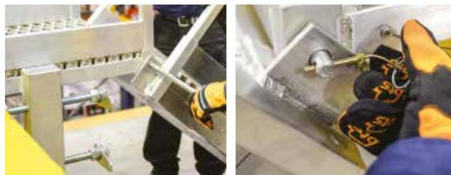
**6** Wenn die Geländer nicht bereits an der Begehung montiert sind, können sie nun durch Einschieben der Geländerpfosten in die auf beiden Seiten der Begehung befindlichen Aufnahmerohre installiert werden.
