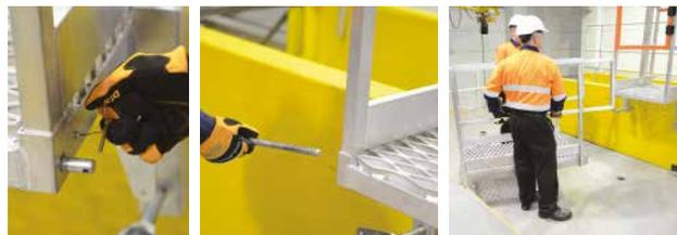
Die Verriegelungsstange wird durch die Drehpunkte auf der Plattform und dem Laufsteg von der gegenüberliegenden Seite des Sicherheitsclips eingeführt (der Sicherheitsclip wird mit Hilfe eines kurzen Bandes, das fest mit der Plattform verbunden ist, befestigt). Bei der Montage der Begehung sind die Finger von Quetschstellen fernzuhalten.
