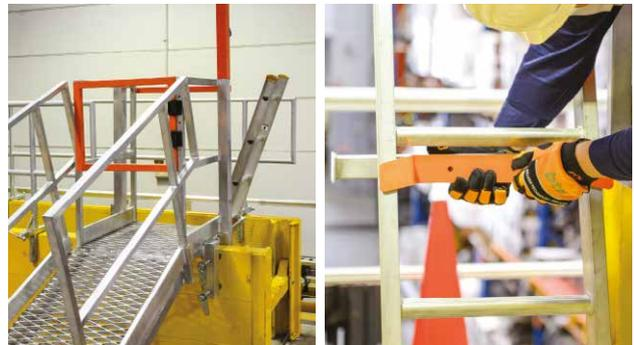
Die Leiter muss mindestens 1 Meter über die Leiterhalterung hinausragen, so dass sie beim Absteigen und beim Aussteigen aus der Baugrube sicher erreicht werden kann (außer wenn die Leiter mit der Vorderkante der Plattform verbunden ist).
