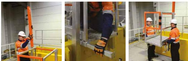
An einigen Standorten kann es erforderlich sein, dass die Monteure einen Sicherheitsgurt tragen und an einem vorübergehenden Absturzsicherungssystem befestigt werden müssen, bevor sie sich der Tragplatte nähern. Bei Bedarf den Gurt montieren und das temporäre Absturzsicherungssystem gemäß den Anweisungen des Herstellers montieren.
